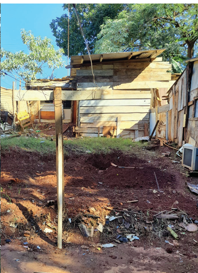
Barraco construído na época da ocupação
